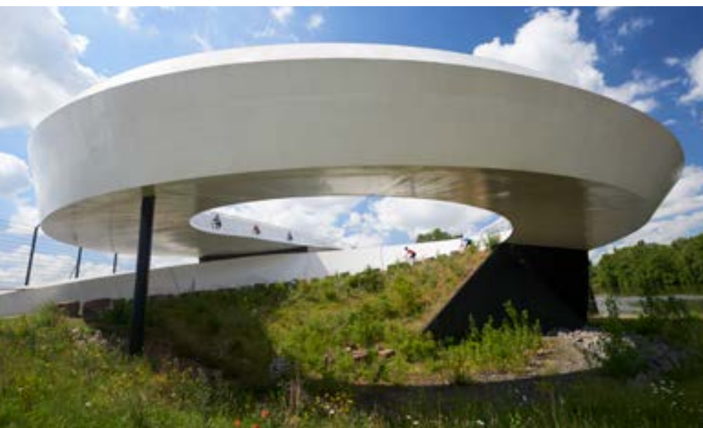
Geh- und Radwegbrücke über der Einfahrt des Ölhafens in Raunheim
